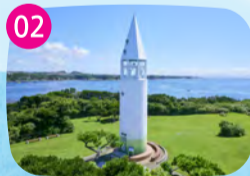
02 安房埼灯台 令和2年に新設された灯台。城ヶ島灯台と対に建っていることから「恋する灯台」に認定されています。
