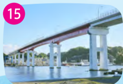
15 城ヶ島大橋 城ヶ島と三浦半島を結ぶ橋。自動車のほか自転車や徒歩でも渡ることができます。夕暮れ時の景色は必見。
