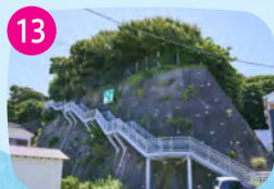
13 津波避難階段 高齢者や身長差に対応できるように、高さを変えた手すりも、数カ所の踊り場が設けられています。
